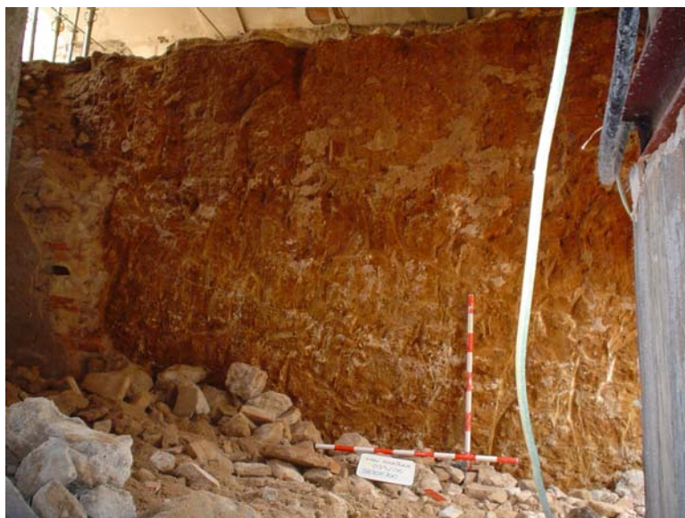
Fotografia del sector 700 i l'enderroc de la UE 715
